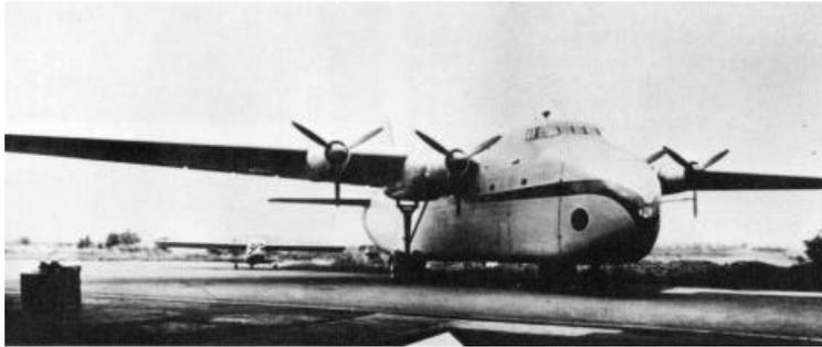
Le SNCAC NC 211 « Cormoran », le 20 août 1948, fut le premier appareil à voler avec des moteurs SNECMA 14 R de 1600 ch. Ce programme fut un vrai désastre, accidents mortels, pannes à répétition des moteurs.
